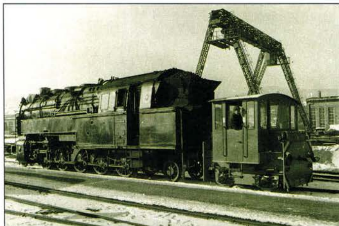
Im damaligen FEW konstruierter und gebauter Prototyp eines Akku-Schleppfahrzeugs (ASF). Die Serienproduktion kam allerdings im FEW nicht zustande. Das in Blankenburg gebaute ASF verblieb im dortigen Bw, hier beim Rangieren der 95 045 in den 60er Jahren.
