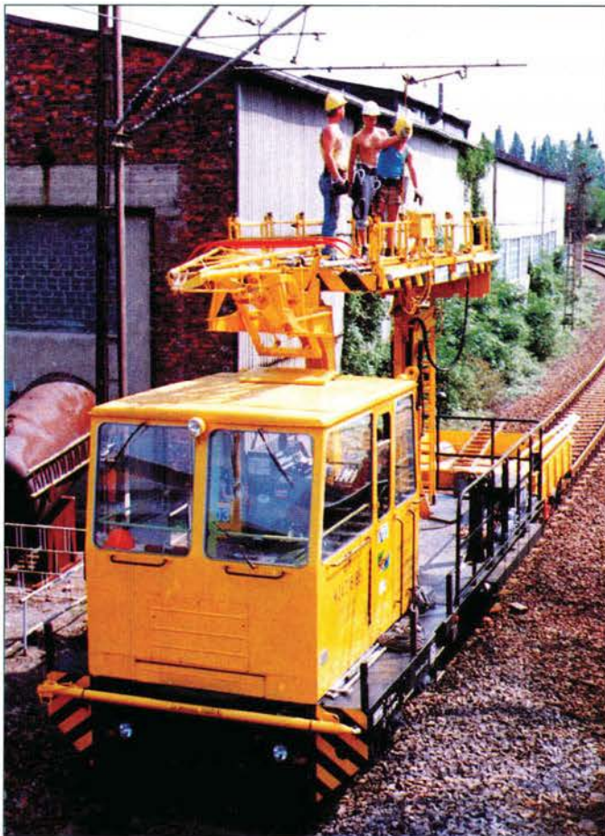
Mehrzweckgerät-Arbeitsbühne (MZA) am 25. Juni 1992 bei Arbeiten an der Oberleitung im Magdeburger Hauptbahnhof.
